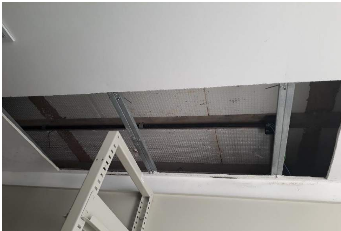
FOTO 1_CAMPUS ESTRUTURAL_TETO EM OBRAS
