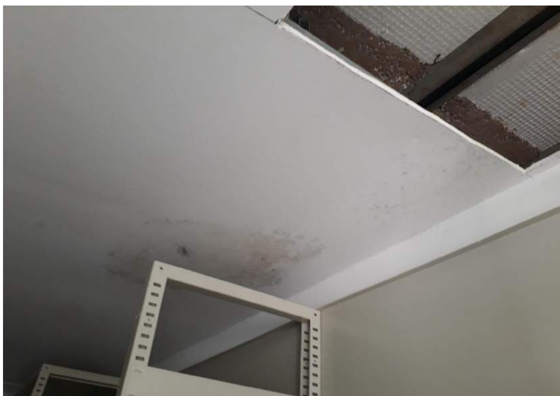
FOTO 3_CAMPUS ESTRUTURAL _MANCHA NO TETO
